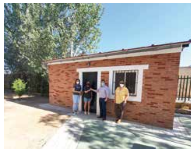
Espacio en el que se ha actuado en el colegio San José de Calasanz
